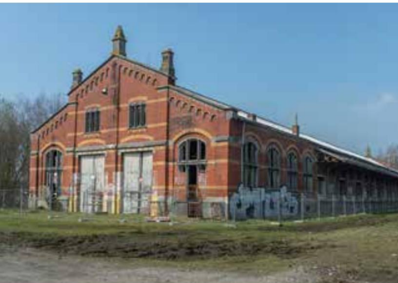
De loods was helemaal vervallen en onderging een grondige renovatie.
